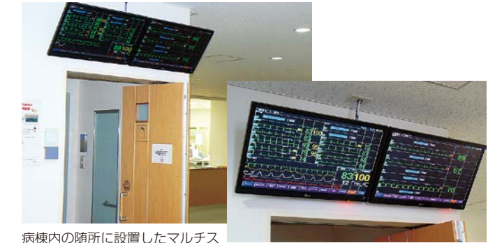
病棟内の随所に設置したマルチスレープモニターシステム。スタッフは病棟のどこにいても心電図モニターの確認が可能です。
