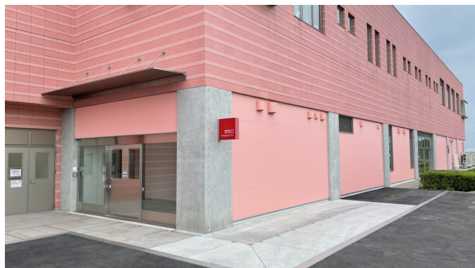
増築エリア(1階ピロティ)
